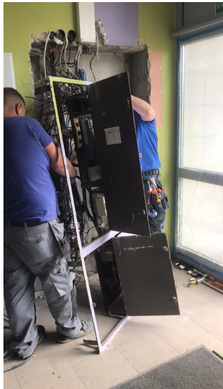
demontaż starej rozdzielnicy elektrycznej
