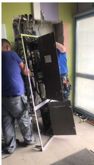
demontaż starej rozdzielniczy elektrycznej
