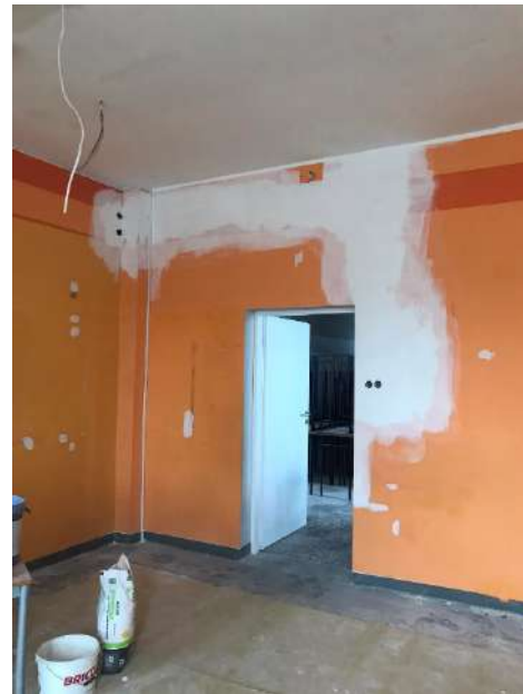
bruzdowanie i doprowadzanie nowych kabli do lamp LED
