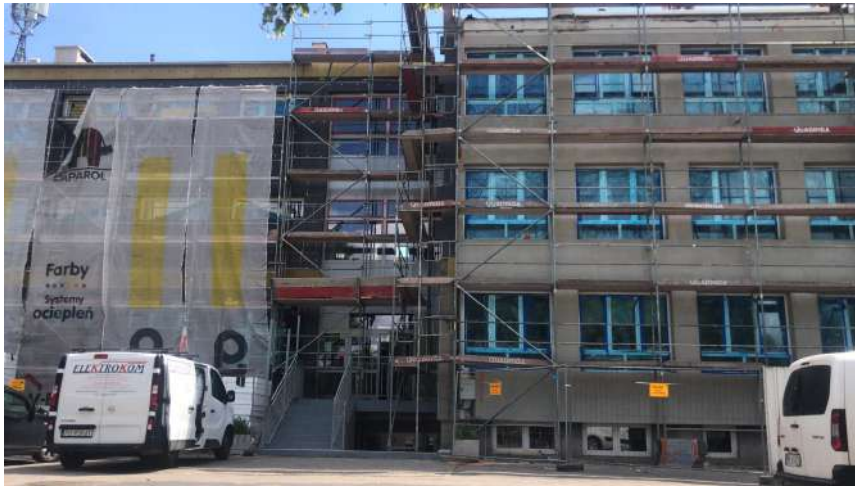
montaż rusztowania
